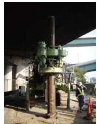
空頭制限下での施工
