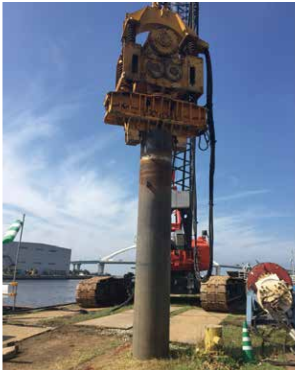
機械式継手付鋼管杭の打設
