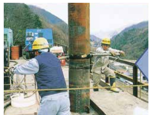
回転バンドを用いたねじ接合の様子
