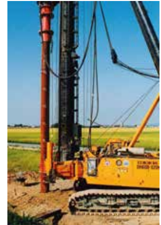
三点杭打機での施工
