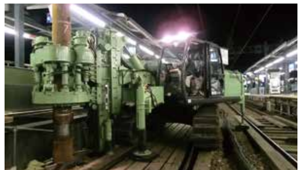
線路内での急速施工の事例
